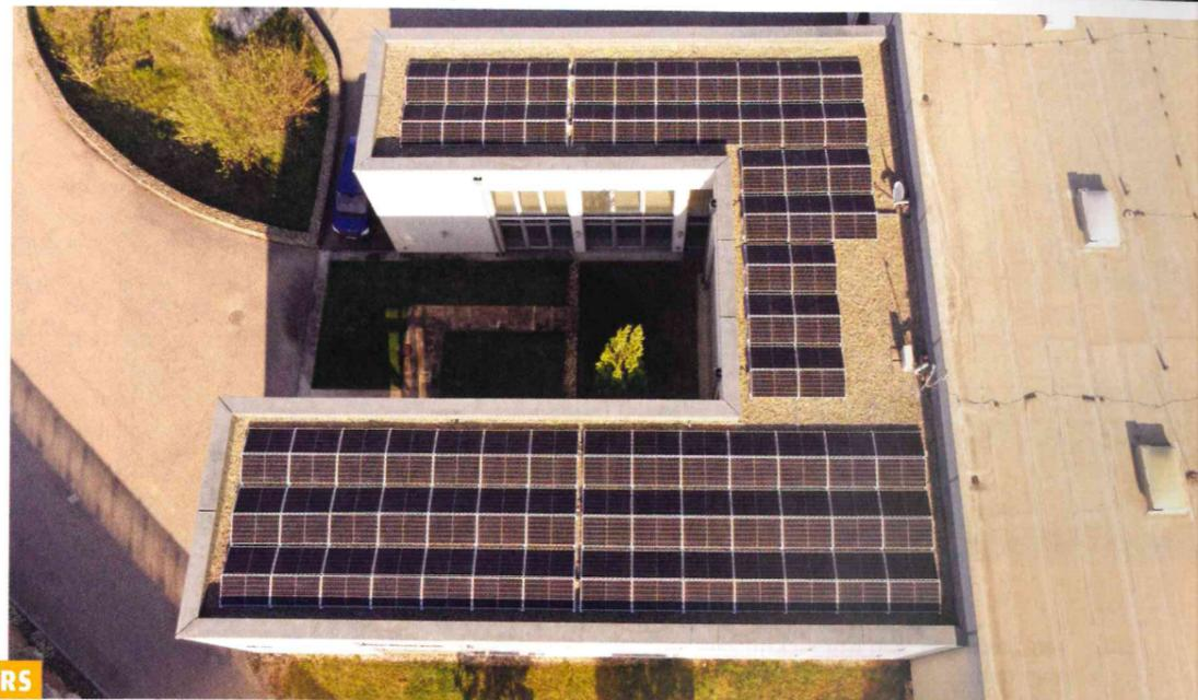
Die 51 kW Photovoltaikanlage am Dach des Betriebsgebäudes der Firma AM Baugeräte ist seit 25. Mai in Betrieb und erzeugte bis Ende September bereits 29.633 kWh Elektrizität.
